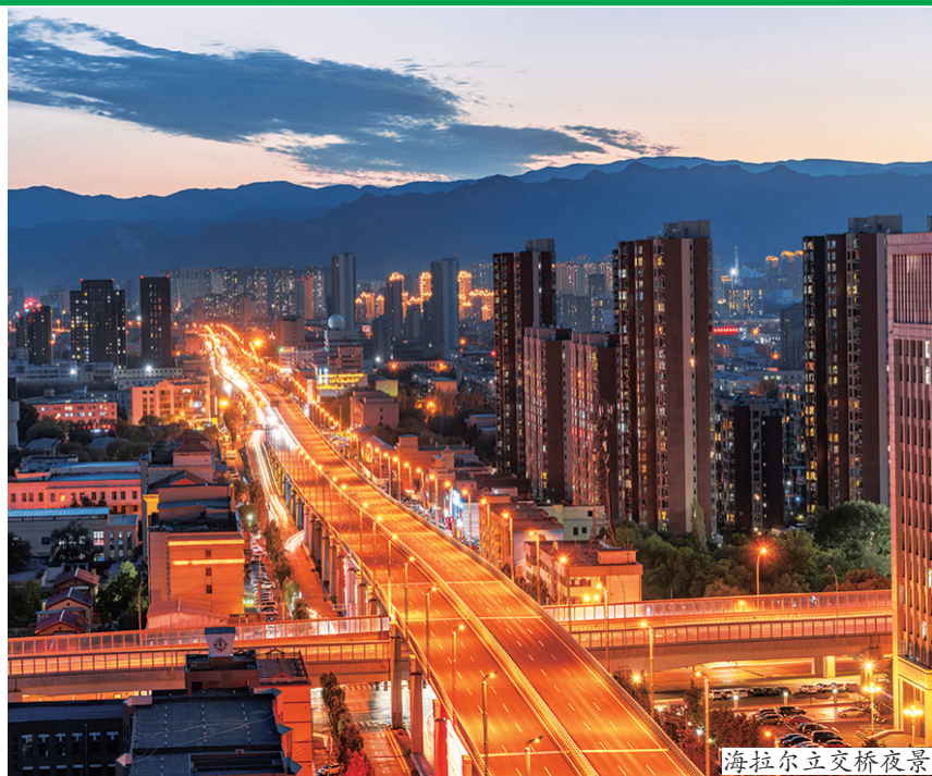
海拉尔立交桥夜景
