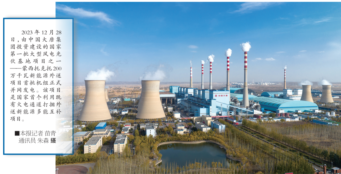
2023年12月28日,由中国大唐集团投资建设的国家第一批大型风电光伏基地项目之一——蒙西托克托200万千瓦新能源外送项目首批机组正式并网发电。该项目是国家首个利用既有火电通道打捆外送新能源多能互补项目。
