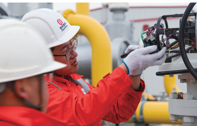
检测维护阀门电动执行结构
