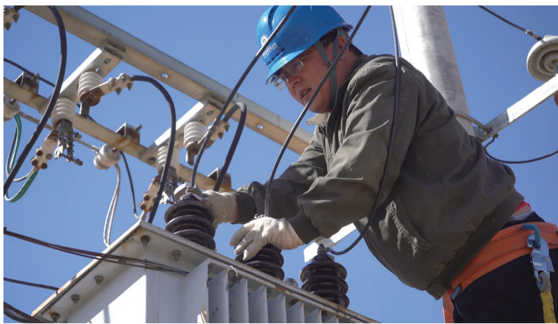
和林县作为农业大县,每年农灌用电负荷较大。内蒙古电力集团呼和浩特和林供电公司结合当地实际,在每年农灌高峰来临前,一方面组织各供电所开展线路特巡,对发现的缺陷提前进行消除;另一方面,根据负荷情况,提前制定线路切割方案,确保线路安全稳定运行,充分发挥电力“先行官”作用,扛起春耕春灌保供电“主力军”责任。图为电力工作人员正在检查线路。
