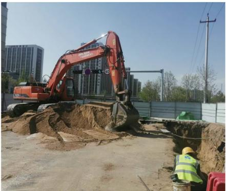
本报讯(记者 刘丽霞)4月24日,记者在位于万通路与东大街交会处东北角的互联互通供热管网东环网建设工程施工现场看到,施工人员正在对开挖路面进行分层回填。该工程于4月11日开工建设,计划5月11日完工。目前工程已开挖、敷设直径900毫
