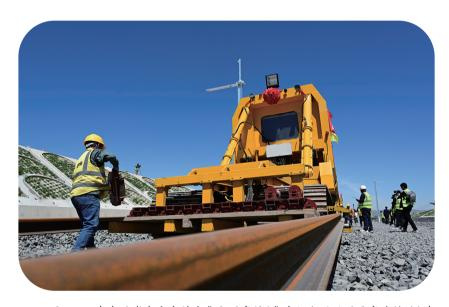
5月15日,在乌兰察布市丰镇市集大原高铁(集宁经大同至原平高速铁路)建 设现场,随着第一对500米长钢轨顺利铺设,标志着集大原高铁建设全线开始铺 轨,该条高铁建设进入冲刺阶段。
