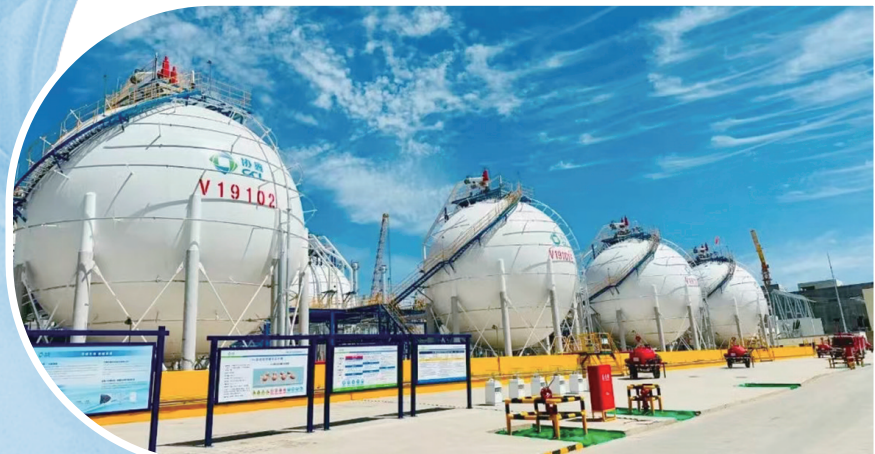
内蒙古鑫环硅能科技有限公司年产10万吨颗粒硅项目
