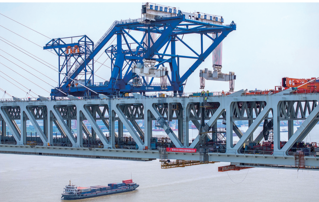
6月9日，大桥建设者在常泰长江大桥主航道桥合龙段进行作业（无人机照片）。6月9日，随着主航道桥钢桁梁合龙段焊接完成，常泰长江大桥顺利合龙。历时5年，这座世界最大跨度斜拉桥实现全线贯通，预计明年4月底前具备通车条件。
