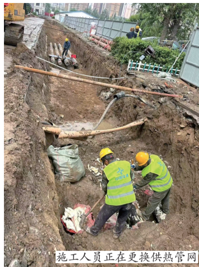
施工人员正在更换供热管网
