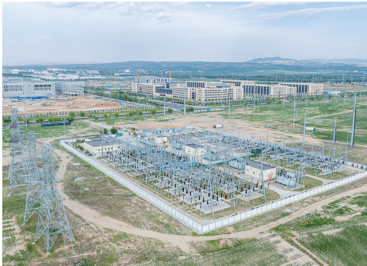
7月2日,随着内蒙古电力集团呼和浩特供电公司盛乐220千伏变电站1号、2号主变扩建工程顺利完成投产送电,呼和浩特市首座“百万”容量220千伏变电站诞生。
