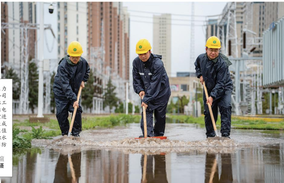
雨后,内蒙古电力集团呼和浩特供电公司东郊220千伏变电站工作人员不间断对站内电缆沟、排水渠、配电室进行巡视,预防积水造成设备故障,同时组织值班员及时对设备区积水进行清除处理,筑牢防汛防汛安全堤。
