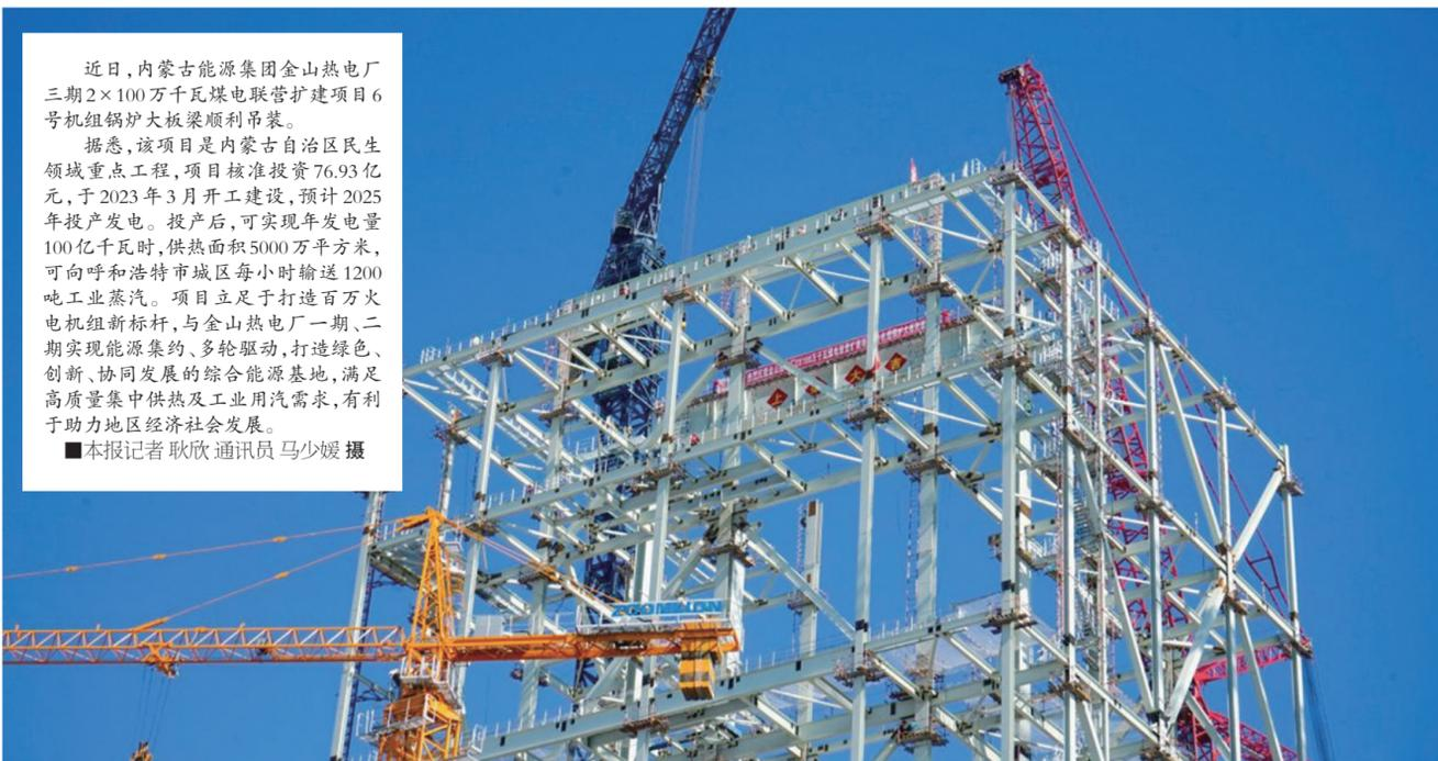
近日,内蒙古能源集团金山热电厂三期2×100万千瓦煤电联营扩建项目6号机组锅炉大板梁顺利吊装。
