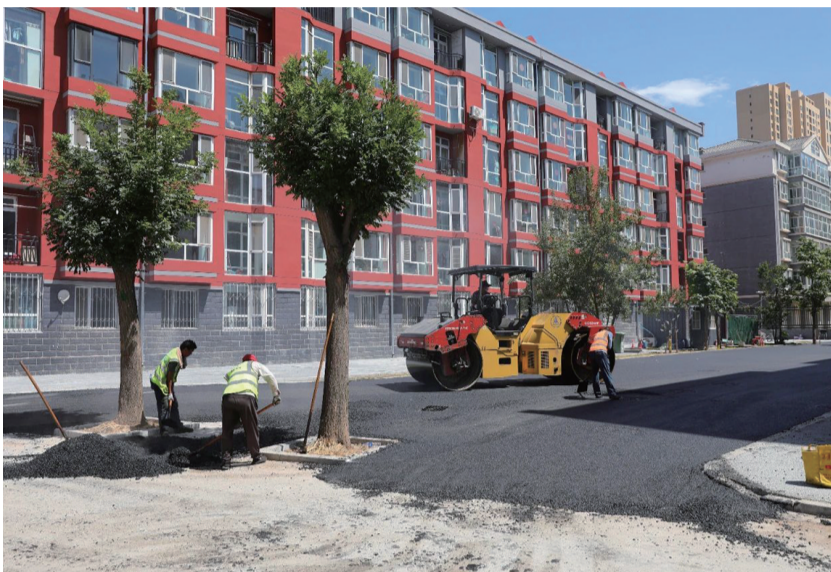
施工人员正在对路面进行铺油和平整
