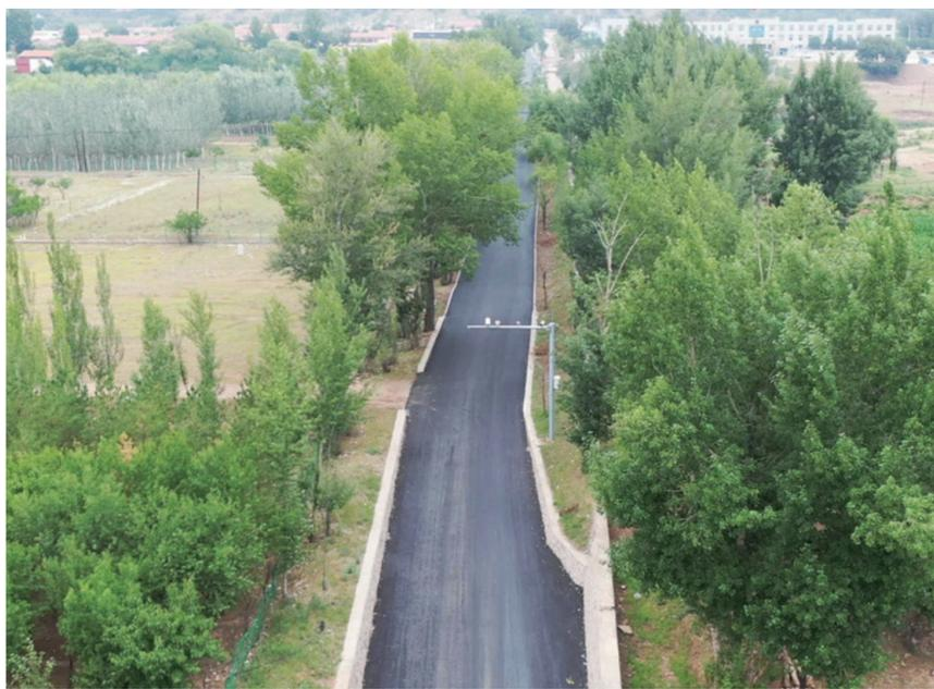
近日，经过升级改造的“军民共建双拥路”修缮完毕正式通车，整条道路平坦开阔、焕然一新。据悉，此条“双拥路”是进出土默特左旗民兵训练基地、土默特左旗察素齐镇东沟村必经之路。近年来，由于人员流量大，过往车辆骤增，导致路面破损严重。土默特左旗人武部积极协调相关部门后，对“双拥路”1.8公里破损路面进行全面修复，将路面由2.8米拓宽至4米，新铺路基厚度12厘米，并浇筑了水泥混凝土，配套完善了路灯、交通标识等道路基础设施，赢得了群众的点赞。
