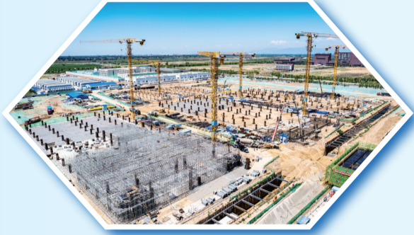
俯瞰中国建设银行内蒙古和林格尔新区数据中心项目
