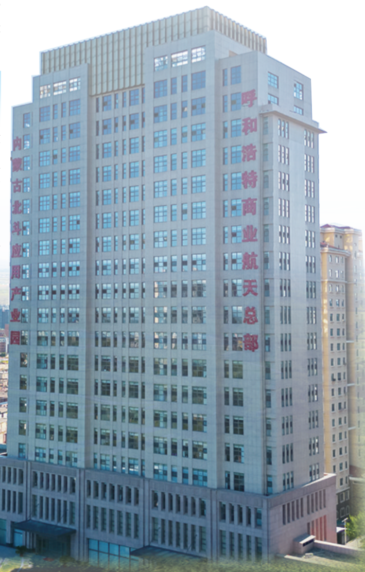
内蒙古北斗应用产业园项目
