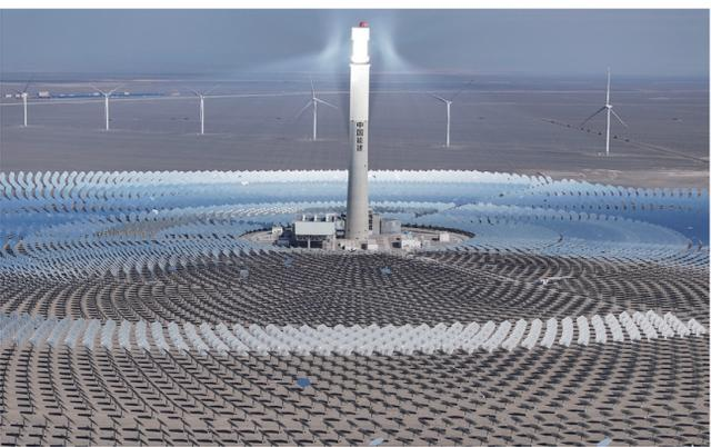
位于新疆哈密市伊吾县淖毛湖镇的国家光热示范项目——熔盐塔式50兆瓦光热发电站(9月12日摄,无人机照片)。
