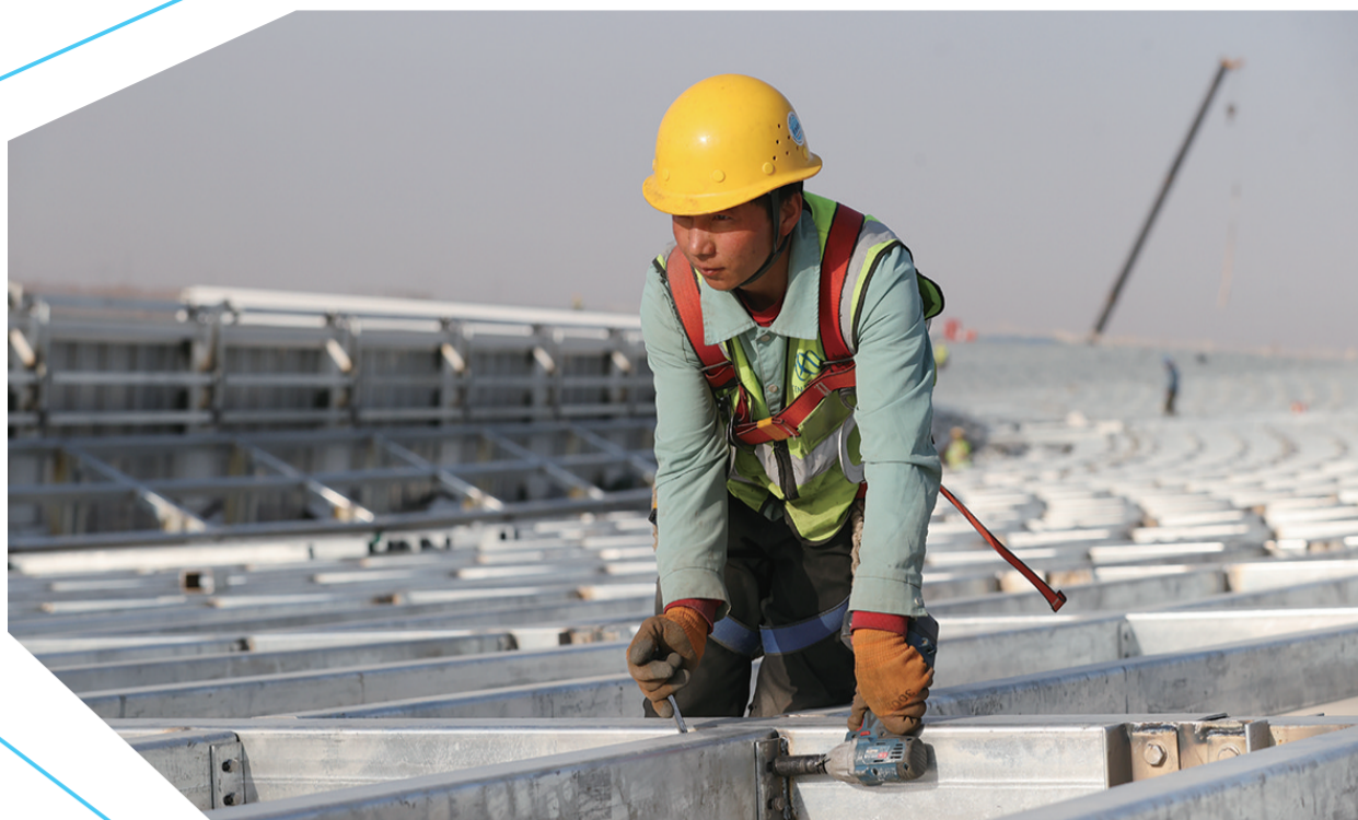
工人固定屋面
