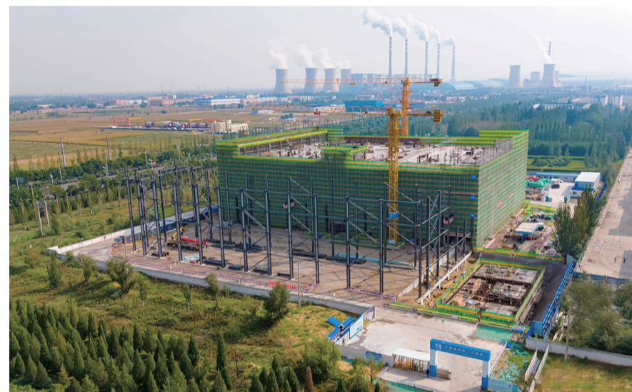
内蒙古常盛制药有限公司国际高端制剂智能制造灯塔工厂项目施工现场
