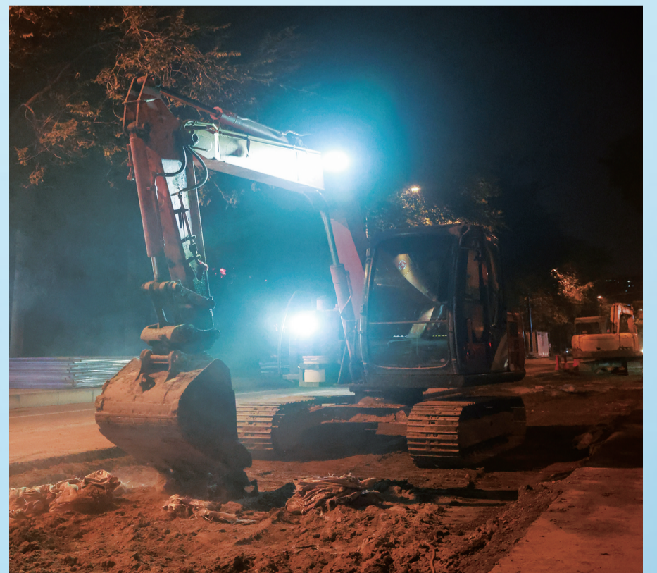
加紧施工作业
