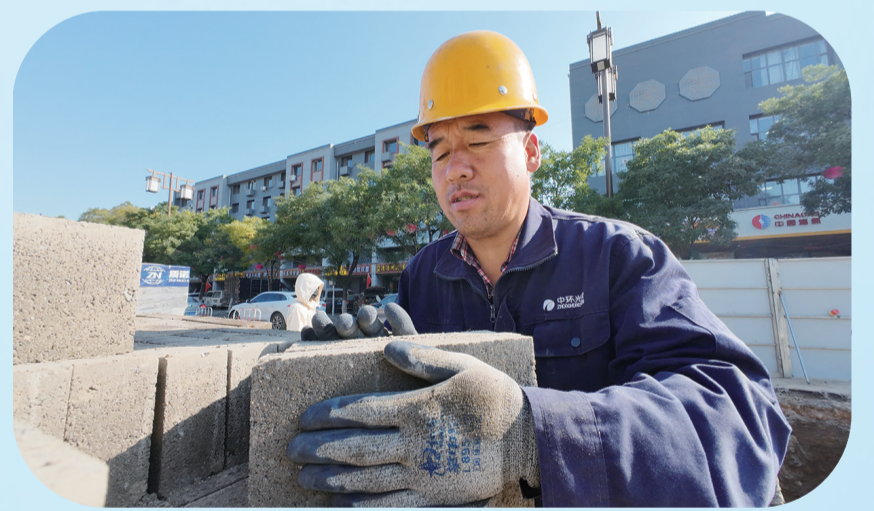
搬运管道防护墙砖材
