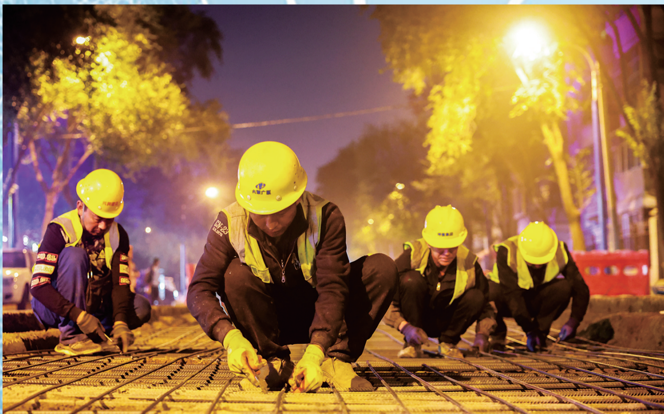
回填路面钢筋加固
