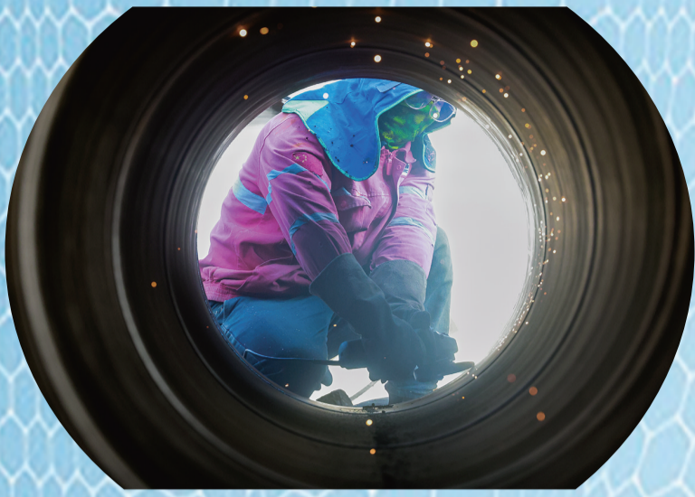
供热管道打磨除锈作业
