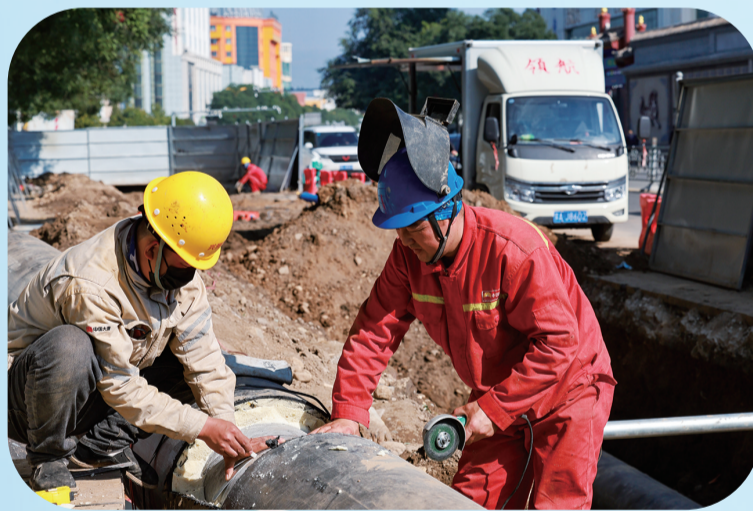
管道安装现场
