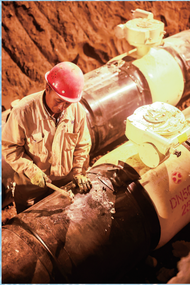
供暖管道接口做保温施工
