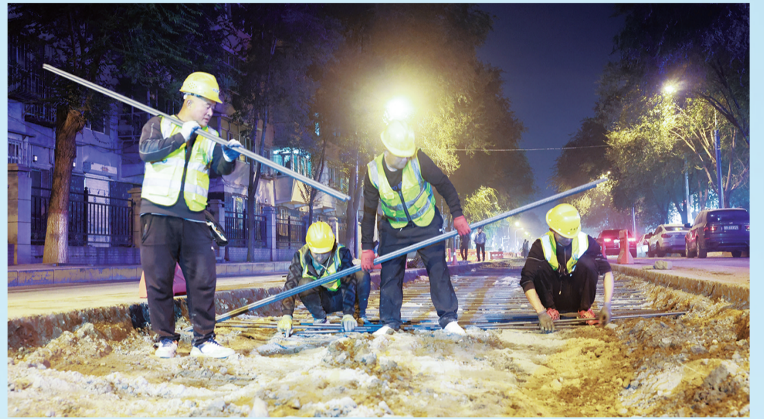
回填路面铺设钢筋
