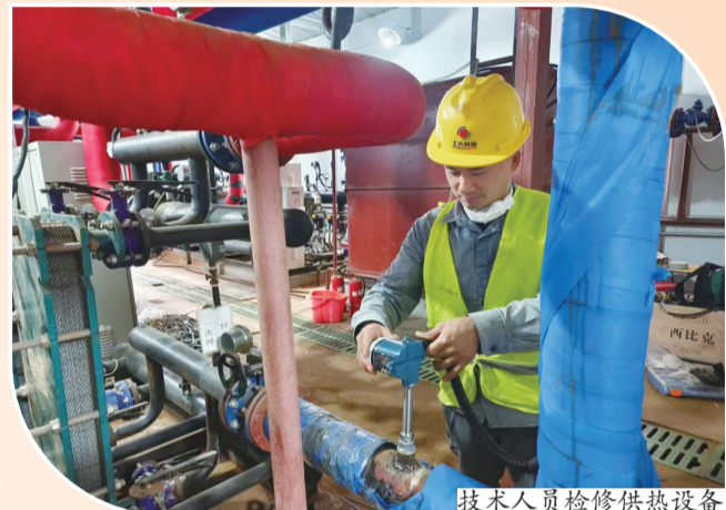
技术人员检修供热设备
