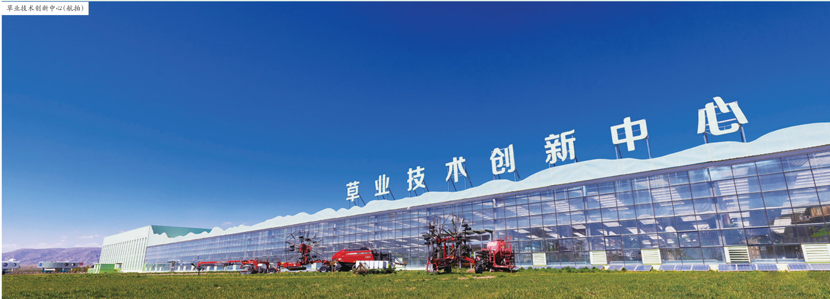
草业技术创新中心(航拍)
