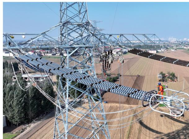
10月23日，工人在河北磁县磁州镇境内的陇东至山东800千伏特高压直流线路工程河北段跨京广铁路建设工地施工（无人机照片）。
