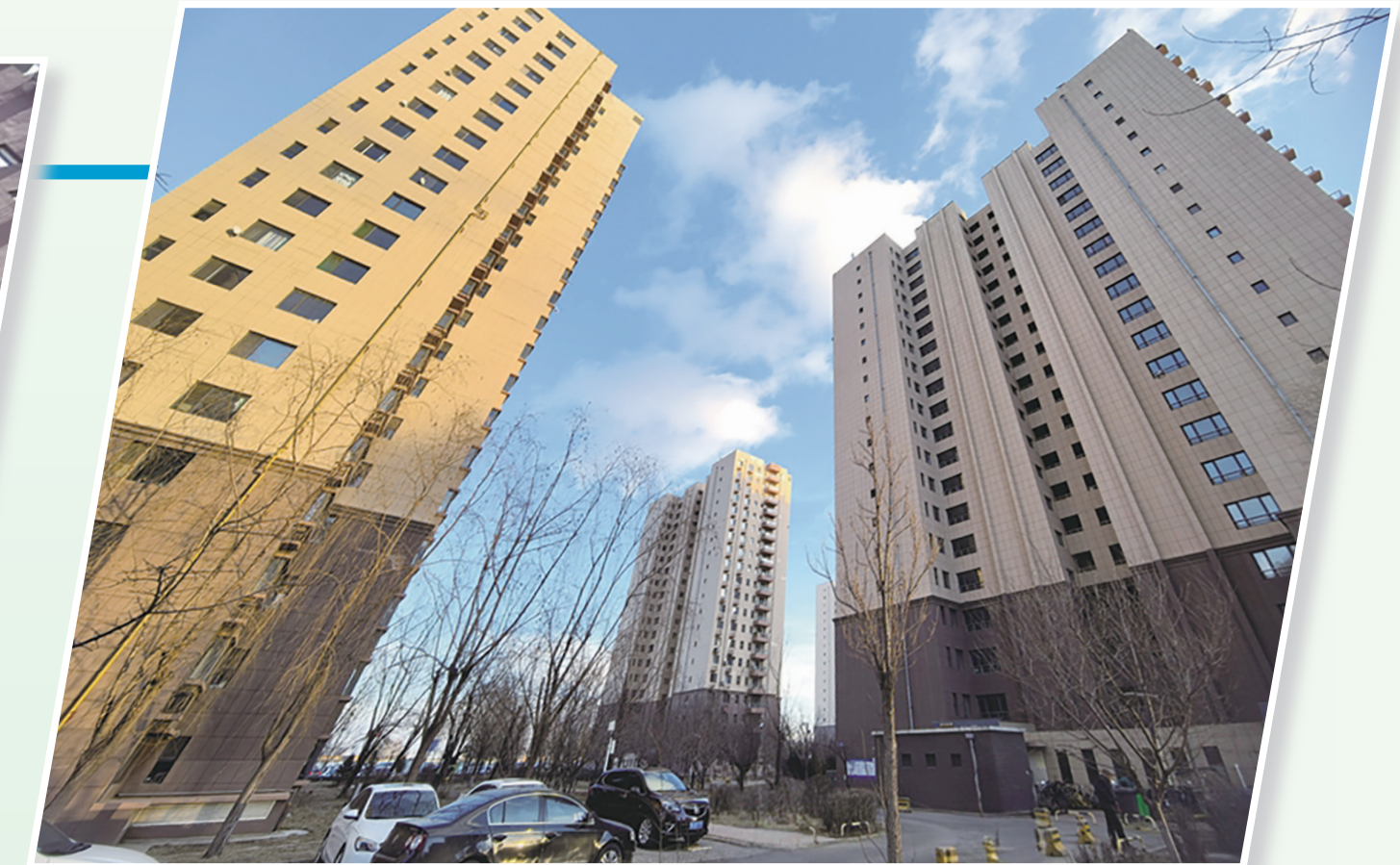
赛罕区阳光美居公租房小区
