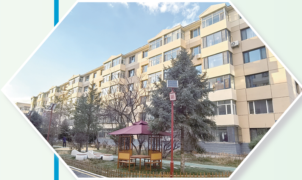
玉泉区绿城小区改造后焕然一新
