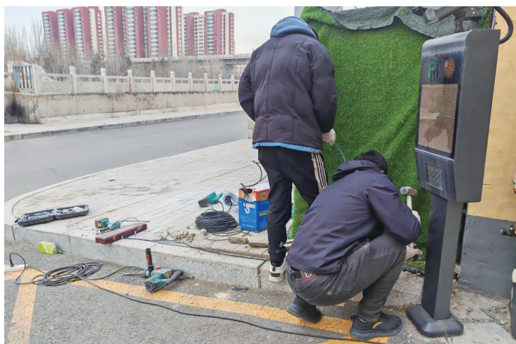
为小区安装监控设备
