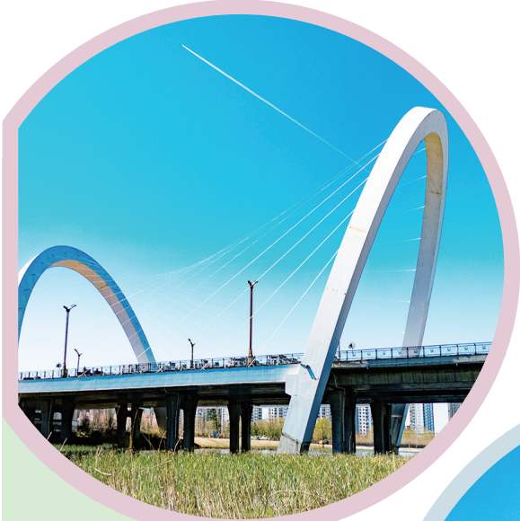
呼伦路跨小黑河大桥
