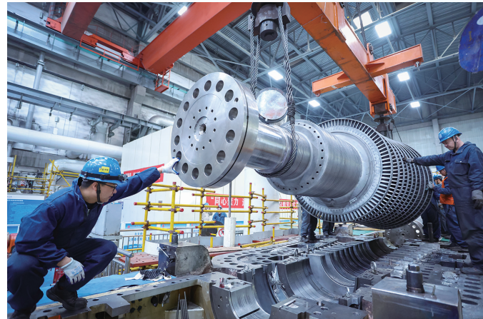
大唐托电职工进行汽轮机转子吊装作业
