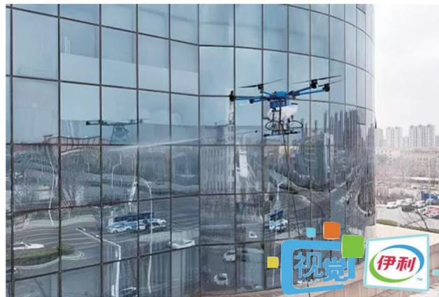
近日,在赛罕区金桥“双创”示范园的一栋写字楼玻璃幕墙外,一款名叫“北洁卫士”的无人机正在高空作业(见图)。通过地面操控,它可以完成100米的高空清洗,通过喷出环保清洁剂降解污渍,一天可清洁8000平方米,相当于40层楼的外墙面积。
