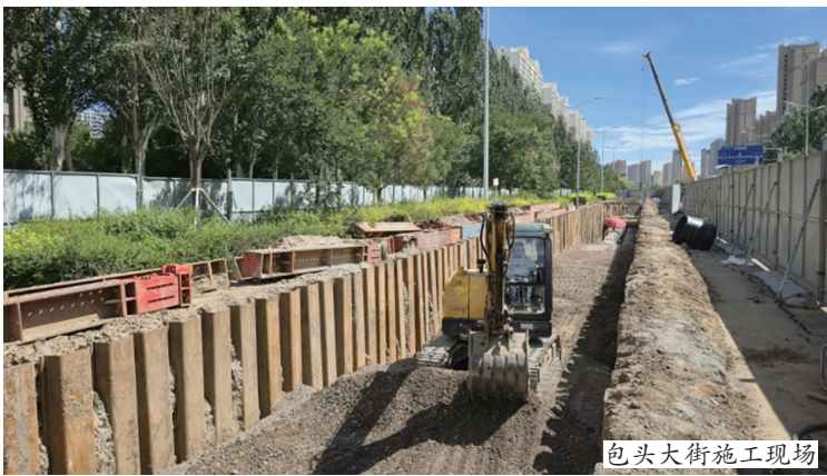
包头大街施工现场
