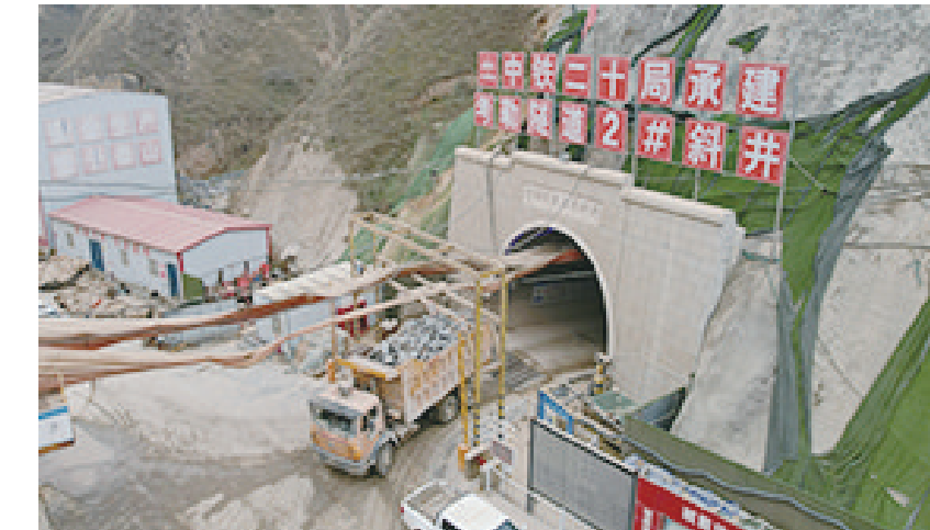
这是兰合铁路考勒隧道2号斜井(11月4日摄,无人机照片)。
