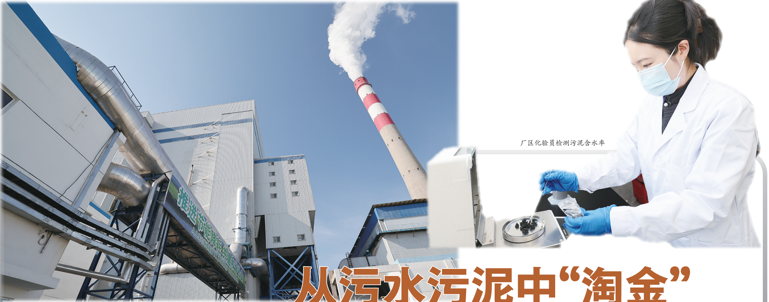
污泥细粉输送管道
