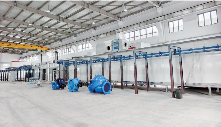
左马装备一期项目的生产车间
