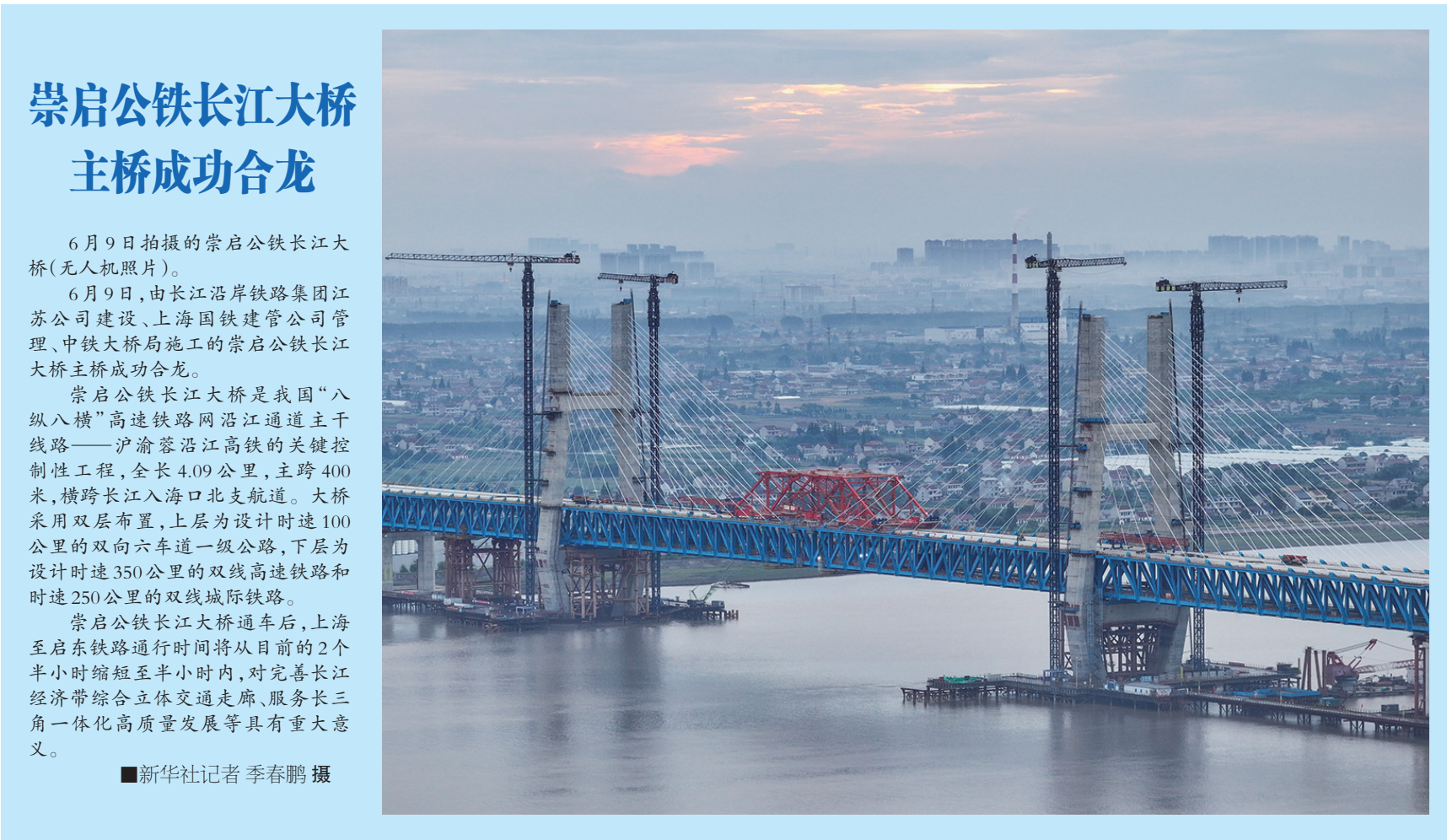
崇启公铁长江大桥主桥成功合龙
