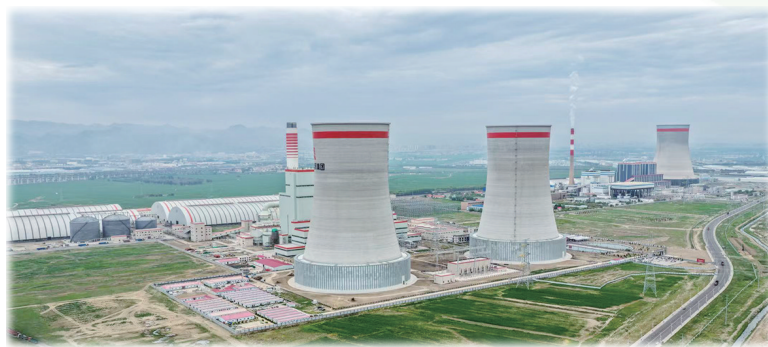
内蒙古能源集团金山第三热电有限公司全景
