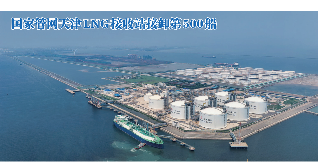
7月19日，一艘来自海外的液化天然气运输船在国家管网天津LNG接收站码头靠泊（无人机照片）。7月19日，一艘来自海外的液化天然气（LNG）运输船顺利靠泊国家管网天津LNG接收站码头。这是国家管网天津LNG接收站自2013年投产运营以来接卸的第500艘LNG船舶。稳定到港的清洁能源进一步充实京津冀地区储气保供资源，为区域夏季用气高峰平稳度夏提供能源保障。■新华社发（杜鹏辉 摄）
