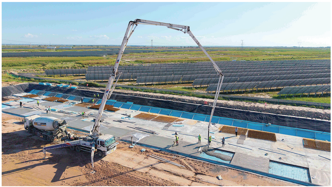
混凝土泵车伸展长臂开展浇筑作业
