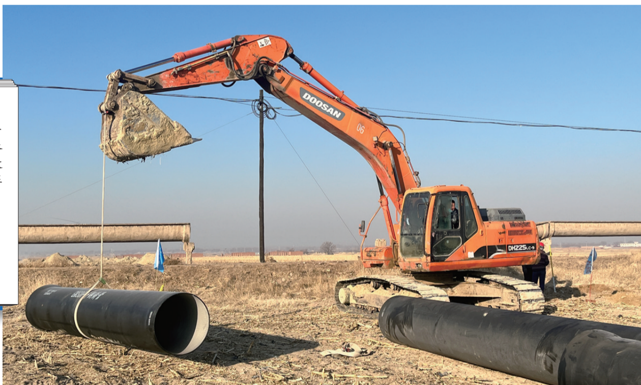
沙尔沁工业区净水厂建设工程是呼和浩特经济技术开发区基础设施建设工程之一，目前该项目正在有序施工中。
