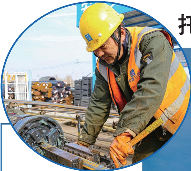
施工人员在安装钢结构
