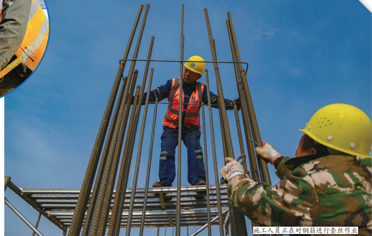
施工人员正在对钢筋进行套丝作业
