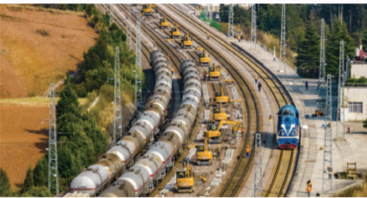
新型换枕设备在铁路沿线一字排开进行枕枕大修(3月8日摄，无人机照片)。
