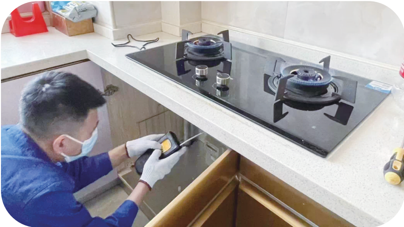
燃气公司工作人员正在检测配套设施。
