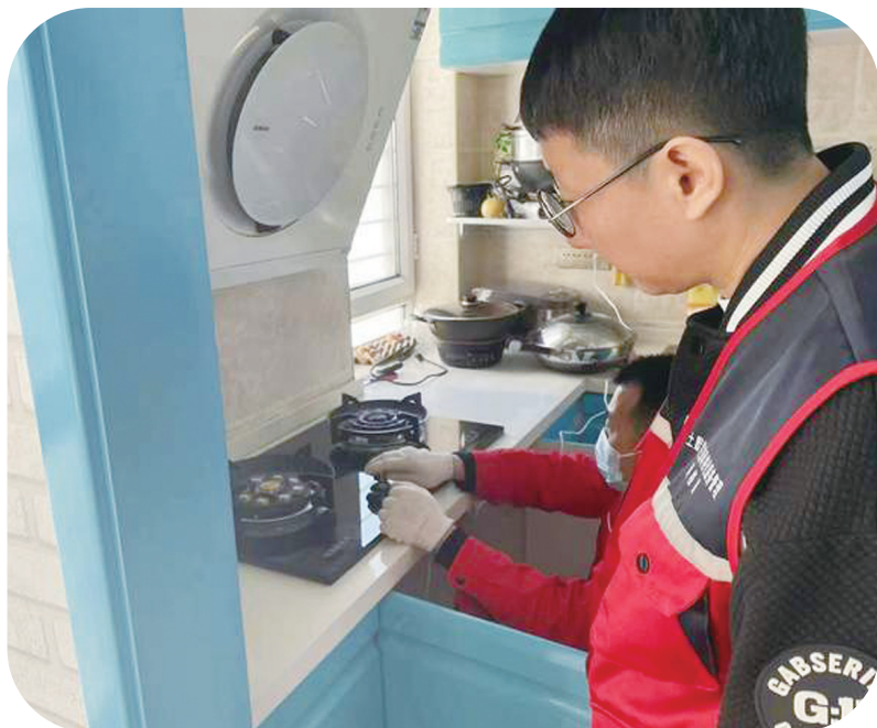
燃气公司工作人员正在接通燃气调试灶具。
