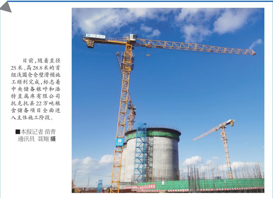
日前,随着直径25米、高28.8米的首组浅圆仓仓壁滑模施工顺利完成,标志着中央储备粮呼和浩特直属库有限公司托克托县22万吨粮食储备项目全面进入主体施工阶段。
