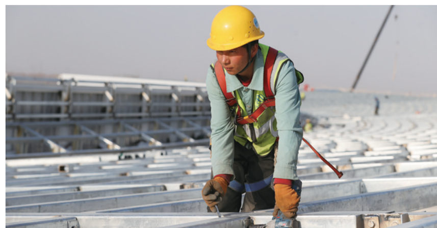
在呼和浩特新机场施工现场进行金属屋面檩条固定
