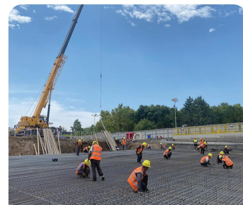
日前,万通路下穿南二环快速路工程已完成南二环南侧所有围护桩和混凝土支撑工程施工,已进入地道结构施工。该工程计划南段8月底完成施工,北段10月底完成施工,全部工程计划年底完成并通车。图为施工人员正在进行底板钢筋的安装施工。
