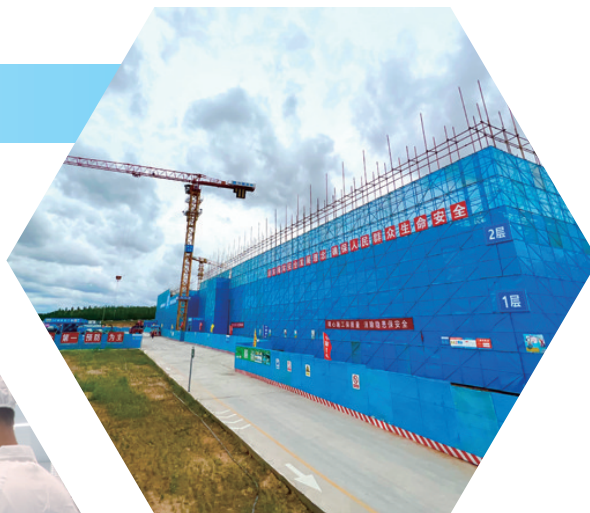
蒙牛九期项目建设工地
