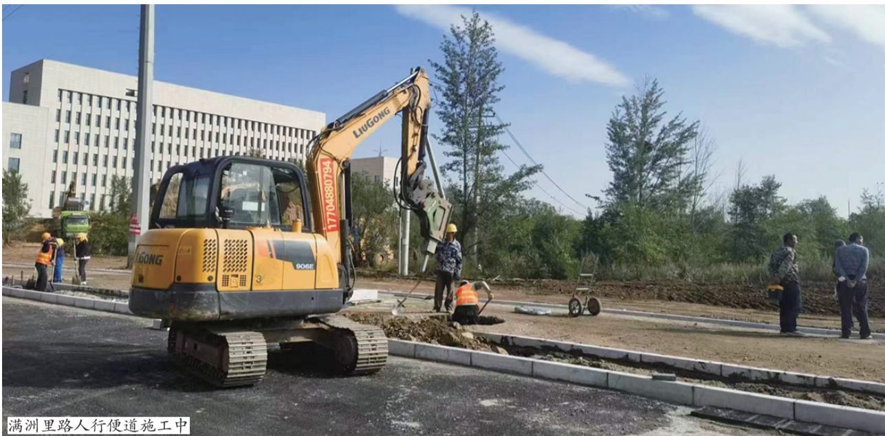
满洲里路人行便道施工中
