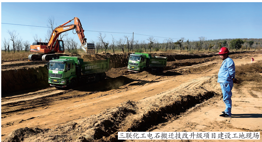
三联化工电石搬迁技改升级项目建设工地现场
