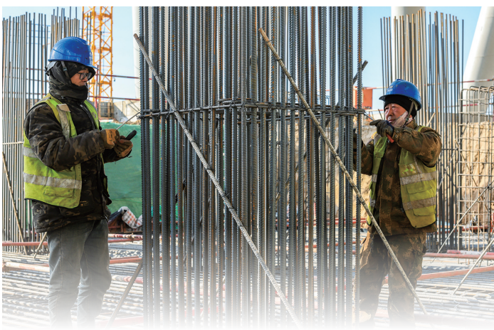
▲施工人员捆绑钢筋。
