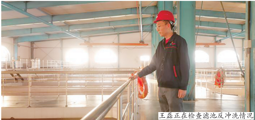
王磊正在检查滤池反冲洗情况
