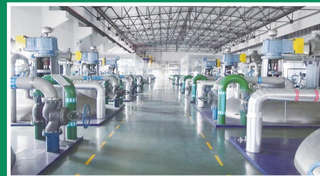
内蒙古金达威药业有限公司生产车间。
