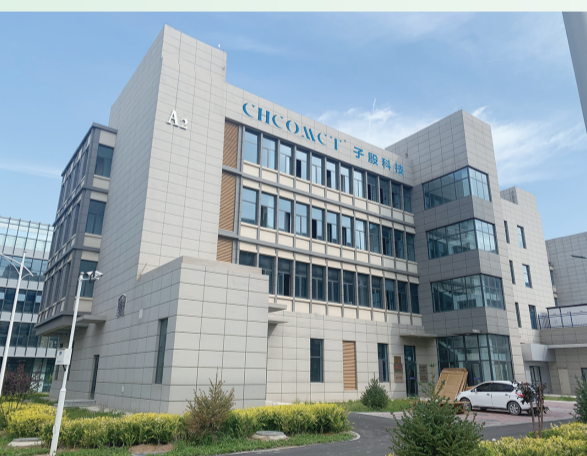
内蒙古子殷科技有限公司大楼
